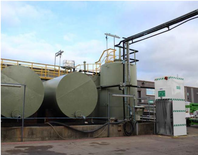
1500-Liter-Tank-Notduschen auf dem Gelände eines Agrarchemieunternehmens, ausgestattet mit einem Streifenvorhang, einem akustischen Alarm, einer Temperaturanzeige und einem Wasserstandsanzeiger.
