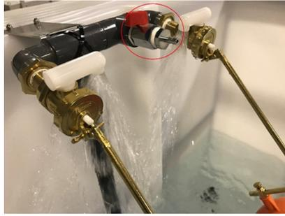
Schließen Sie den Zulauf der Tank-Notdusche an die Wasserversorgung an und füllen Sie den Tank.
