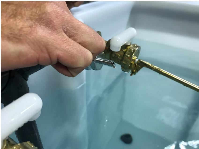
Wenn das Wasser die Markierung A am Siphon-Ablassventil erreicht hat, kann die Ablassfrequenz über das manuell betätigte Wasserablass-Regelventil eingestellt werden.
